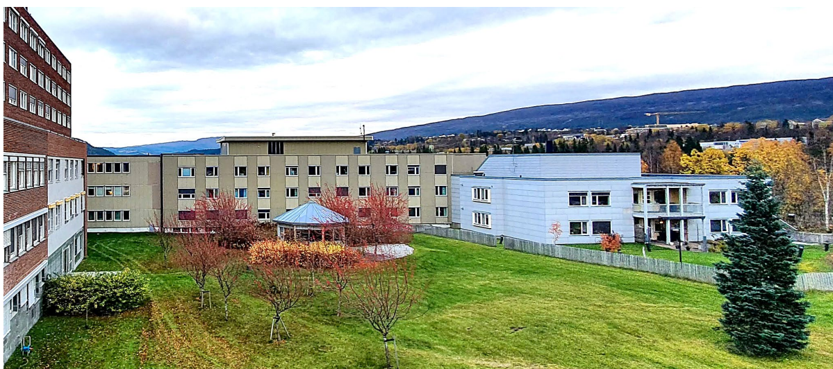
Fasade Fløy B mot vest. Grønt bygg fra 1981. Blått bygg fra 2005.
