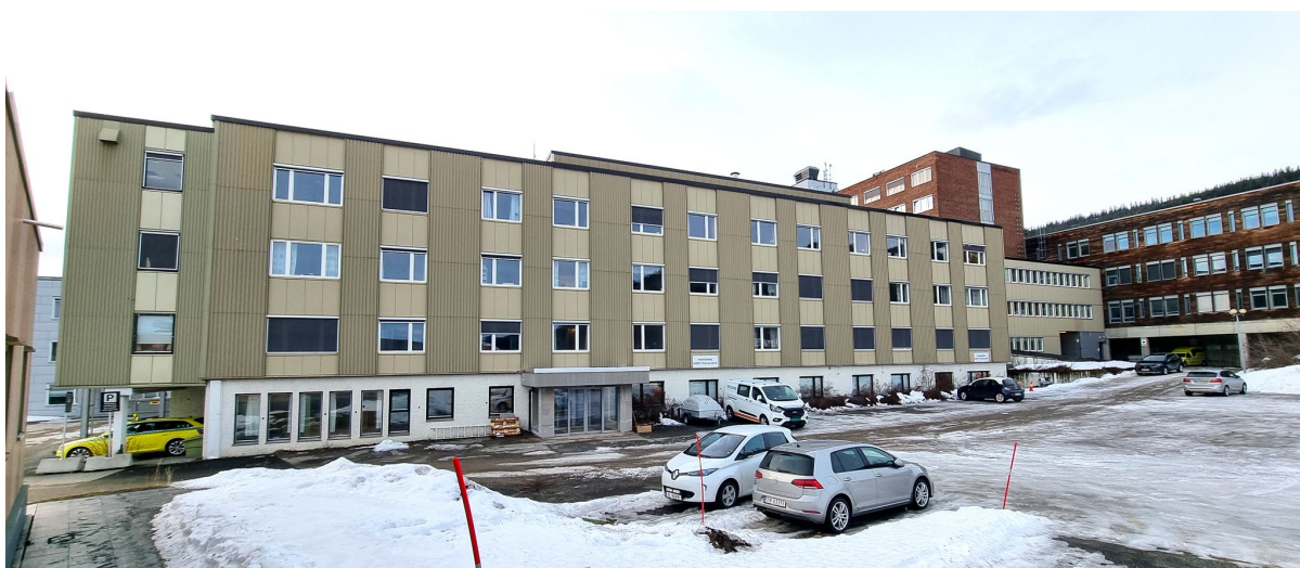
Fasade mot øst. Grønt bygg fra 1981.
