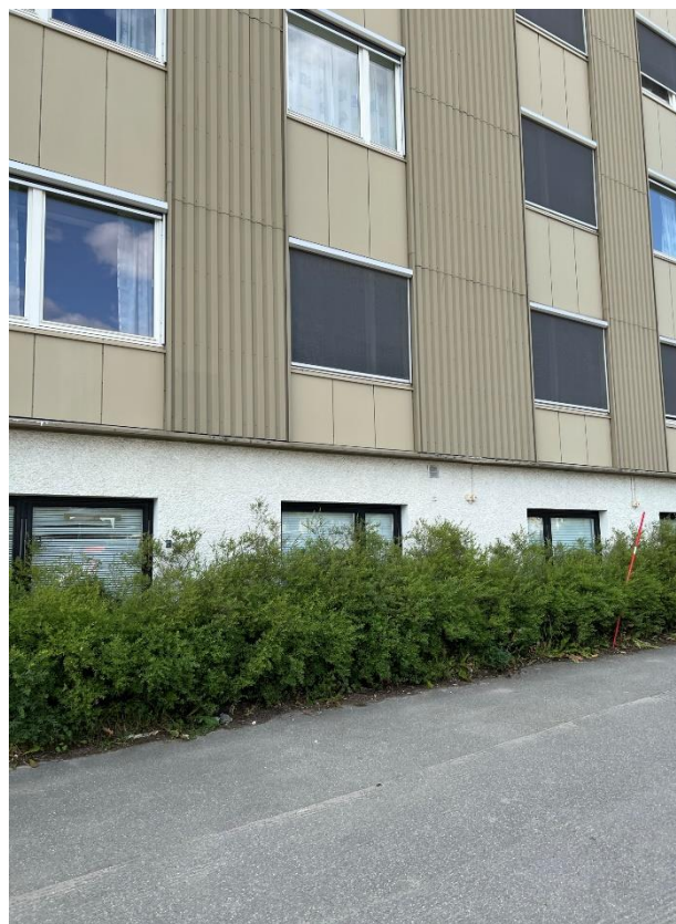
Figur 7 Mye vekster helt inntil kjellervegg. Fasade øst.
