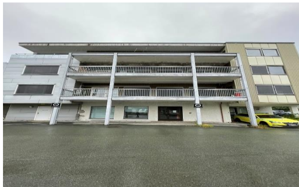
Figur 3 Fasade mot sør.
