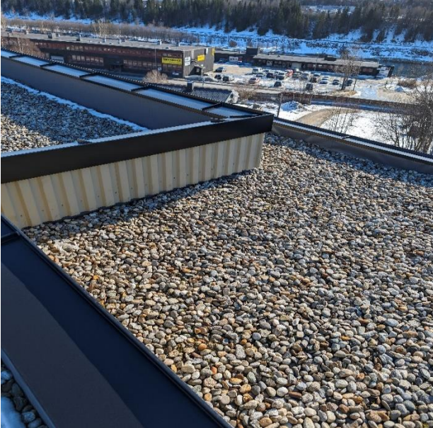
Figur 20 Tekking er dekket med vasket elvestein.
