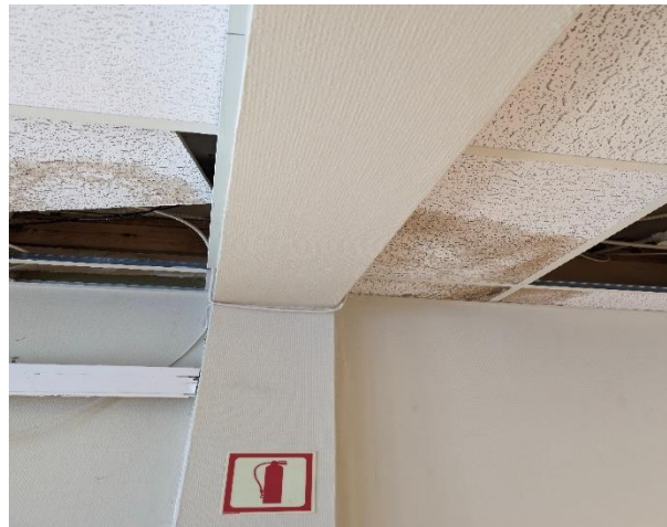
Figur 29 Fuktutslag i kjeller.
